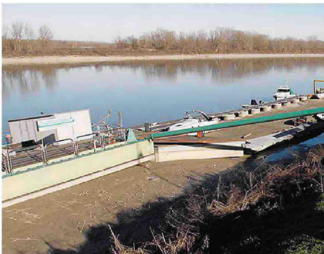
L'attracco del porto di Boretto adagiato sul fondale del fiume in secca
