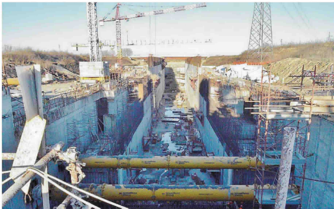
MONTICELLI - Il sopralluogo ieri pomeriggio al cantiere della nuova conca di Isola Serafini (foto Lunardini)
